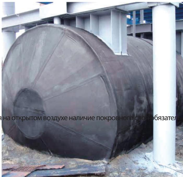
При прокладке изолированного оборудования на открытом воздухе наличие покровного слоя обязательно.
