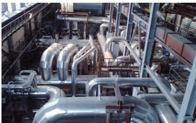
ТРЕХСЛОЙНАЯ СИСТЕМА ПОКРЫТИЙ AL CLAD/WHITE CLAD ПОЗВОЛЯЕТ ЗАЩИТИТЬ ПОВЕРХНОСТЬ ИЗОЛЯЦИИ ОТ УФ-ЛУЧЕЙ, МЕХАНИЧЕСКИХ ПОВРЕЖДЕНИЙ, АТМОСФЕРНЫХ ВОЗДЕЙСТВИЙ, ПРЕКРАСНО ПОДХОДИТ ДЛЯ САНИТАРНОЙ ОБРАБОТКИ И ПРИМЕНЕНИЯ В ПРОМЫШЛЕННОСТИ
